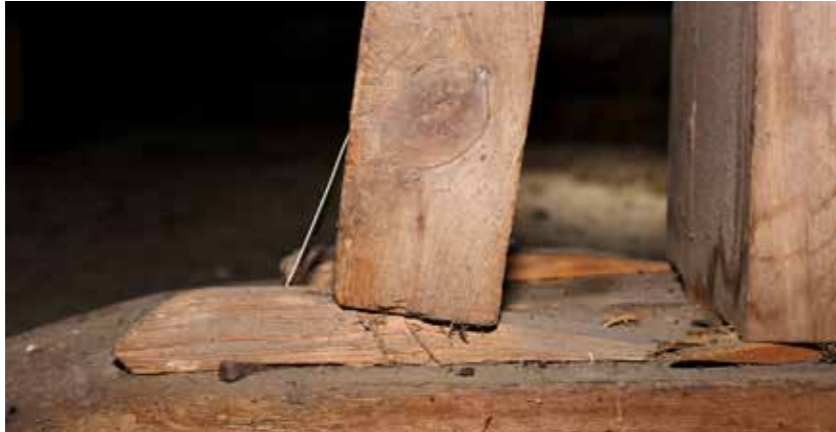
Kilen løfter beinet litt ut av tapphullet i fotplaten. Foto: Thor-Aage K. Heiberg.
